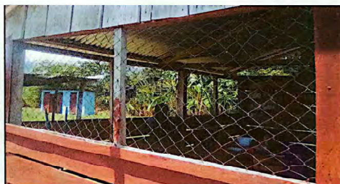
Foto 4: SE REALIZARÁN LOS CAMBIOS DE VENTANAS.
