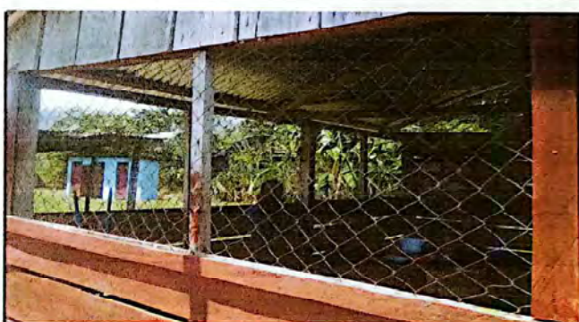
Foto 4: SE REALIZARÁN LOS CAMBIOS DE VENTANAS.
